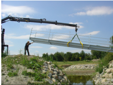
Schlossermeister Eisenbarth legte bei der Versetzung der Brücken selbst Hand an.
