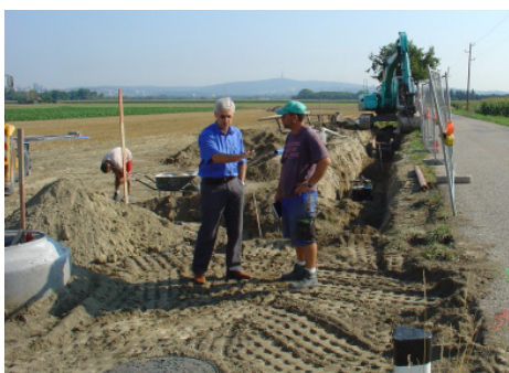
Bürgermeister Hartl im Gespräch mit dem Installateur auf der Baustelle. Eine genaue Koordination der einzelnen Leitungen und Hausanschlüsse im derzeitigen Straßengraben ist wichtig, damit keine Behinderung für die nachfolgenden Grabungen entstehen.
