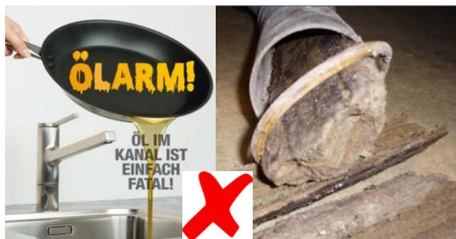
Verstopfung durch Altöl im Abflussrohr
