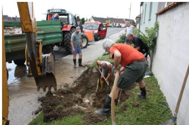
ten um die Wette: „Wir haben kein Wasser“ – so alle Anrufer zeitgleich. Der Sekretär übernimmt vor Ort die mobile Telefonzentrale. Strom- und Postkabel liegen genau über der Hauptleitung und müssen händisch freigelegt werden. Nach zwei Stunden ist die leckende Stelle gefunden und von Schlamm gereinigt, Ersatzteilmaterial wird mithilfe von gfGR Meinczinger zusammengesucht. Zwei Anhänger Schlamm und Erde
