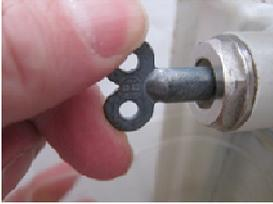
Das Heizsystem sollte regelmäßig auf vorhandene Luft im System überprüft und gegebenenfalls entlüftet werden.
