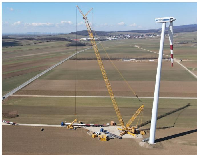
Um den Abbau mit schwerem Gerät bewerkstelligen zu können, wurden vorab die Wege verbreitert und in Stand gesetzt. Die Windräder wurden mittels enormen Kränen abgebaut und an eine litauische Firma verkauft. Der Abbau und Abtransport der 10 Windkraftanlagen erfolgte innerhalb von nur 4 Wochen.
